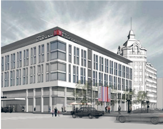
Строительство Hilton Garden Inn в Омске уже началось.
