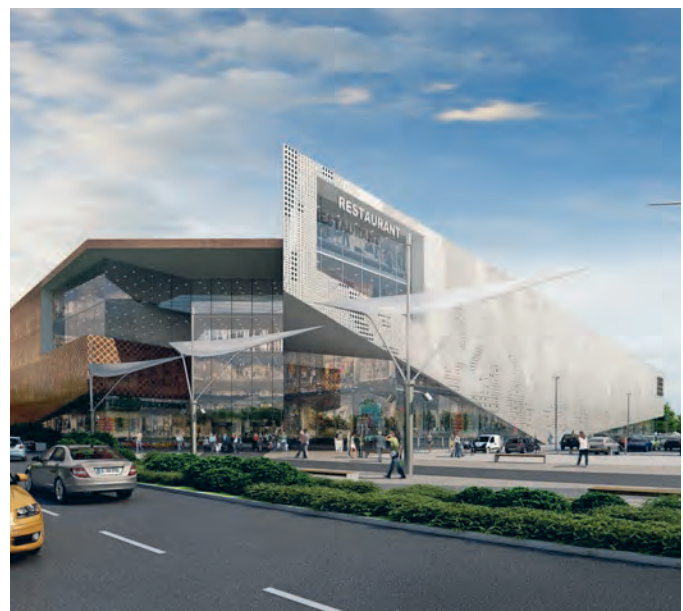
«БУТОВО МОЛЛ» строится на пересечении Остафьевской улицы и Чечерского проезда. Общая
